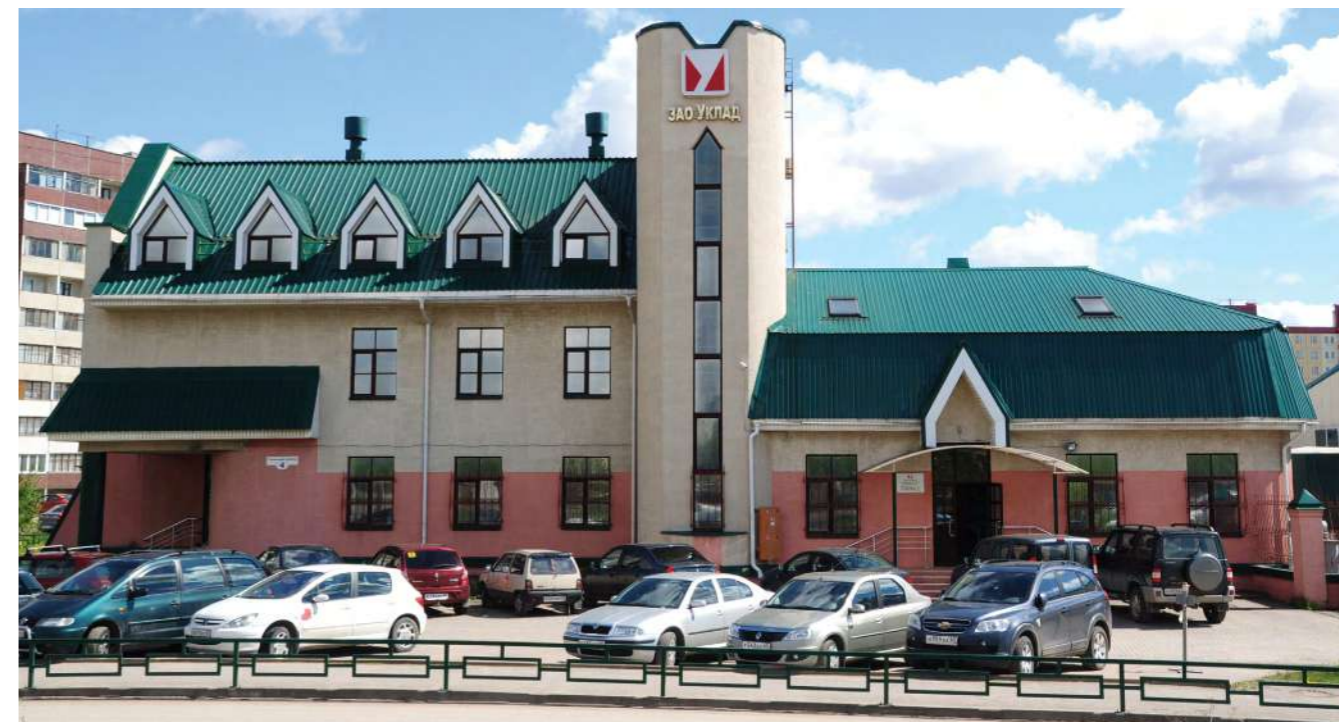
Административно-производственное здание ЗАО «Уклад»
